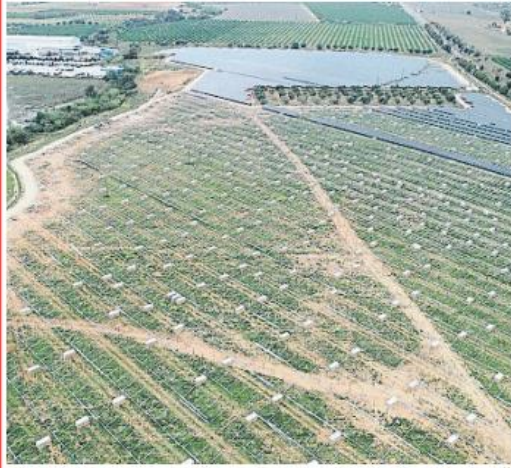
Planta a punto de ser construida en Constantí (17,5 ha)
