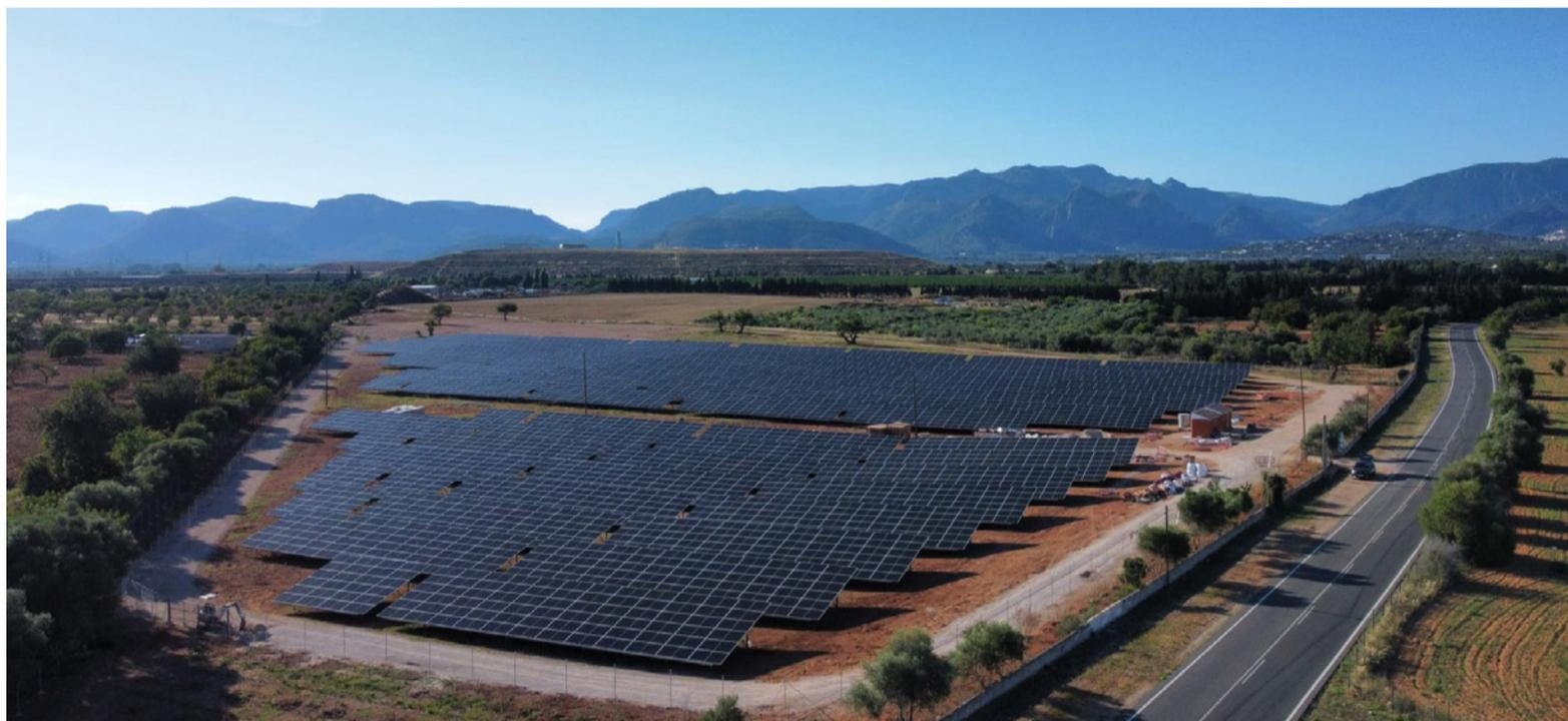
Planta fotovoltaica en Marratxi, Mallorca, 3 MWp en fija 6H.
